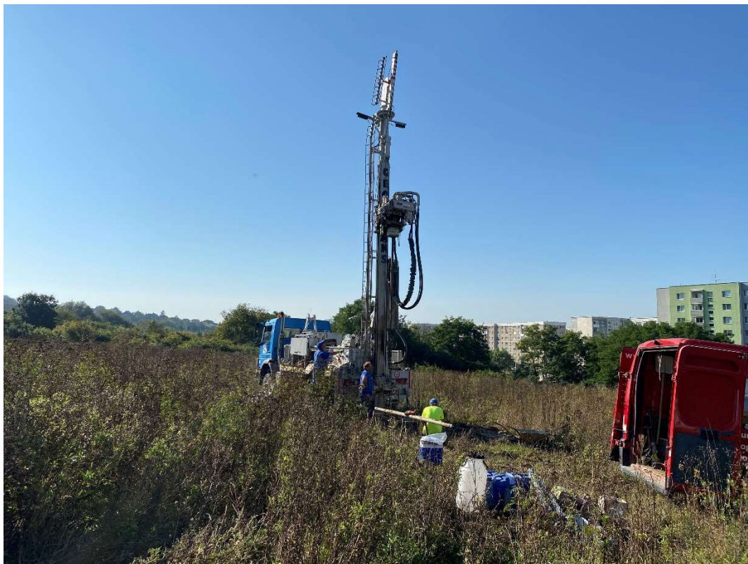
Obr. č. 1 Realizácia vrtu HG – 3
